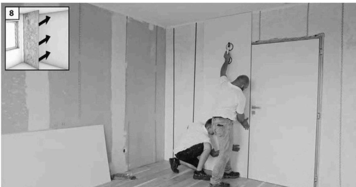
**9. PANEEL NIVELLIEREN** Stecken Sie nach dem Kleben des ersten Paneels die Befestigungsclips ein
