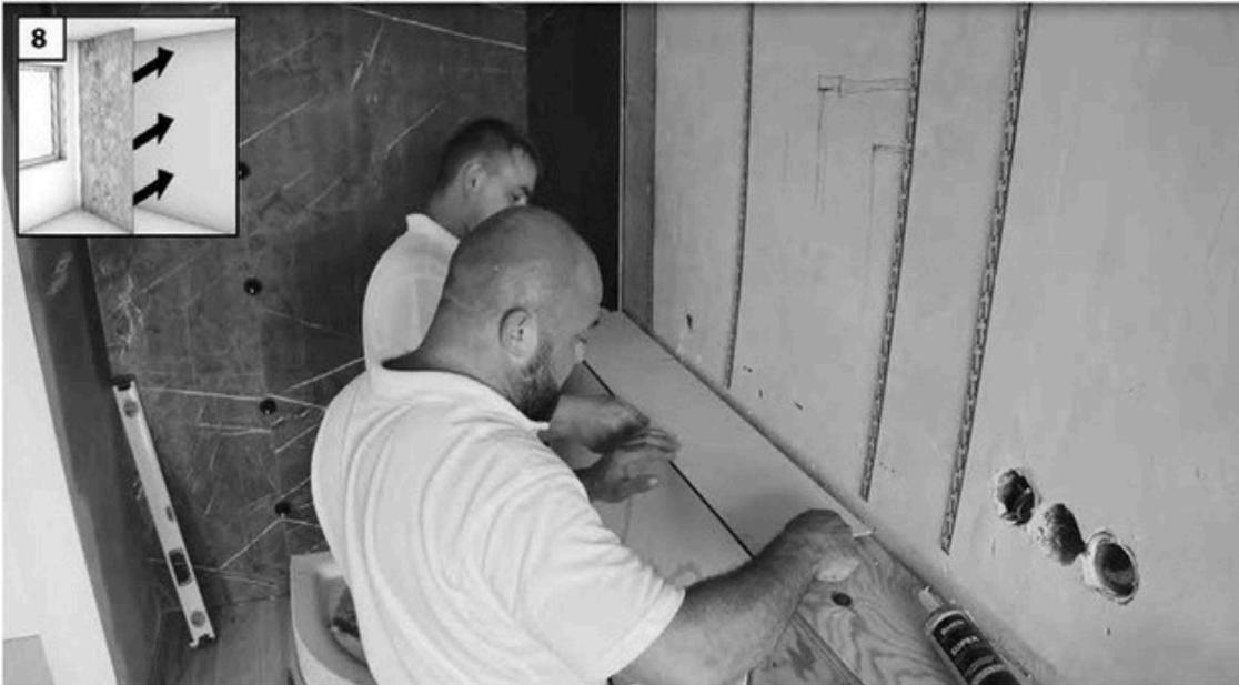
**9. PANEEL NIVELLIEREN** Stecken Sie nach dem Kleben des ersten Paneels die Befestigungsclips ein
